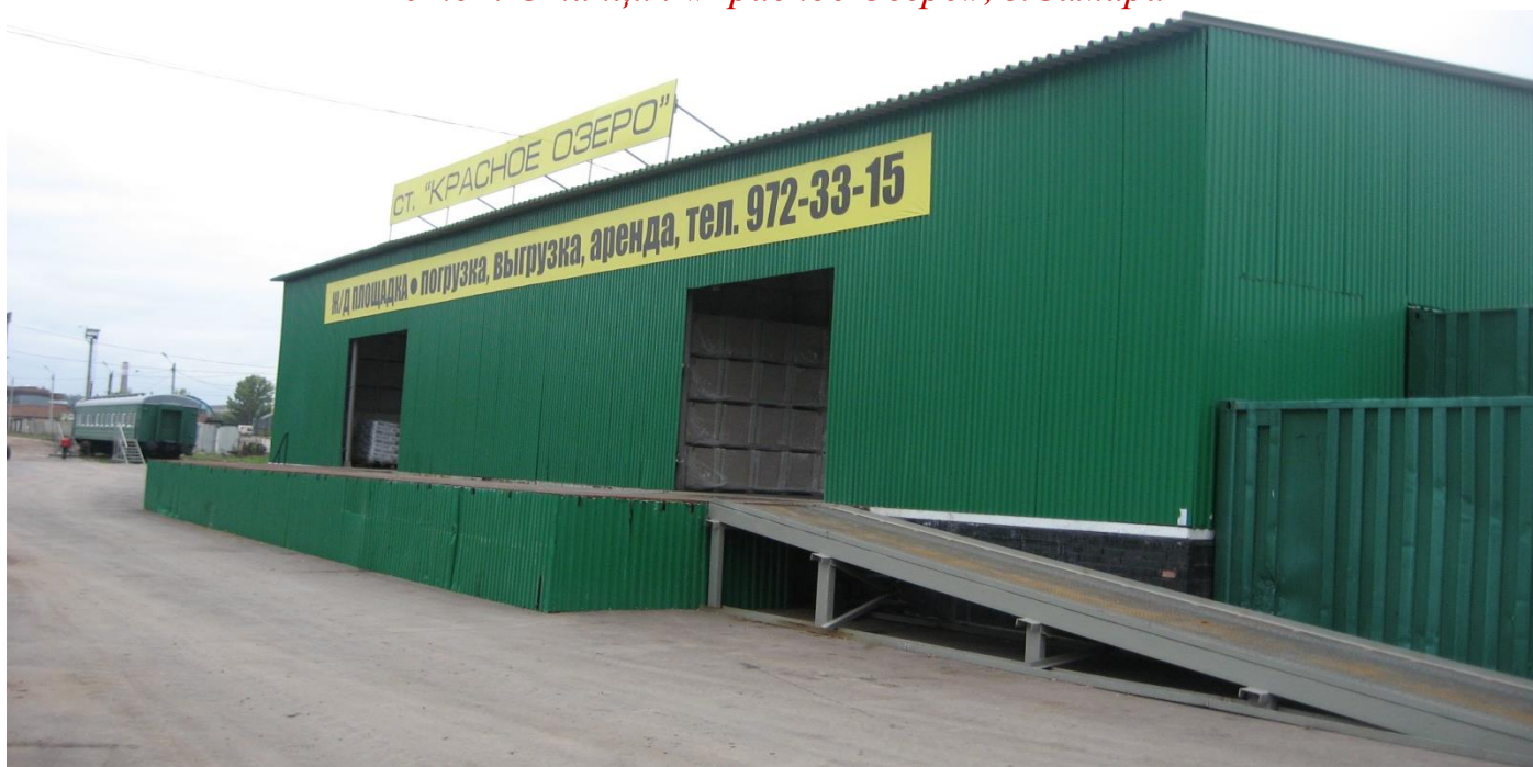
Фото1.1. Станция «Красное Озеро», г.Самара
