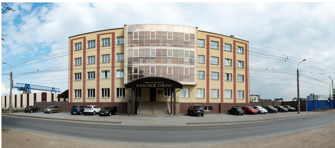
Фото1. Станция «Красное Озеро», г.Самара
