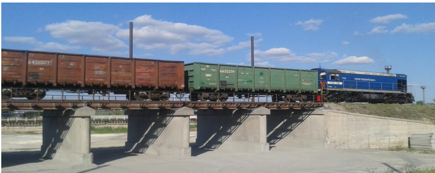
Фото 4. Повышенный путь в г. Пензе.
